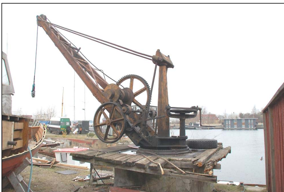
Her ses kranen, som er ved at blive flyttet fra sit fundament i Københavns Havn.
